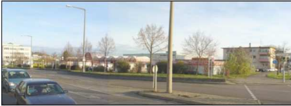
Die Kreuzung Flachter Straße./Hemminger Straße muss attraktiver gestaltet werden
