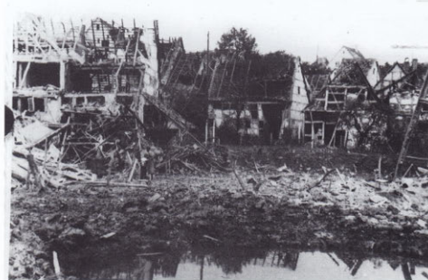
Zerstörte Häuser an der Kimmichstrasse
