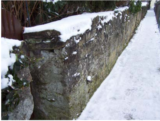
Weilimdorfer Ortsmauer am Verlobungswegle Im Mittelalter Einfriedung mit Graben, dem sog. Landgraben (Lagerbuch 1509)
